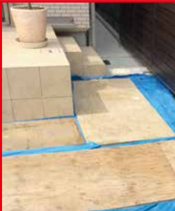
圧着・養生の様子
