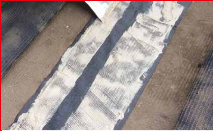
ジョイントシートに接着剤を塗布する様子 (写真は下地が土)
