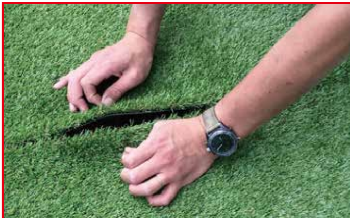
継目を調整し、貼り合わせている様子
