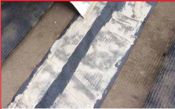
ジョイントシートに接着剤を塗布する様子 (写真は下地が土)
