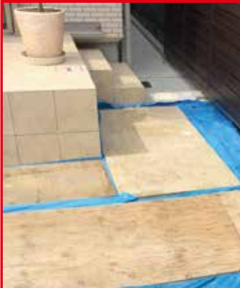
圧着・養生の様子
