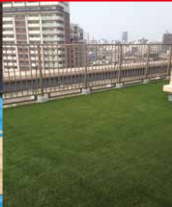
施工完了後の様子
